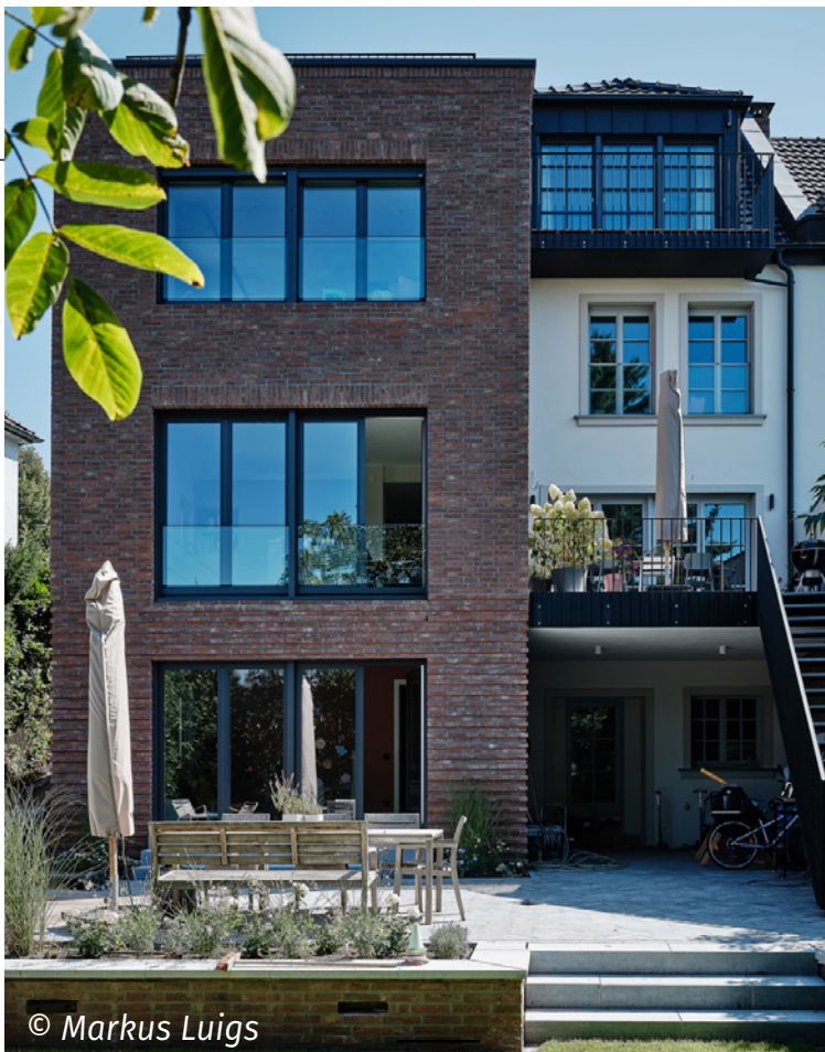
Stadthaus in Bilk – Sanierung und Erweiterung durch einen Anbau
